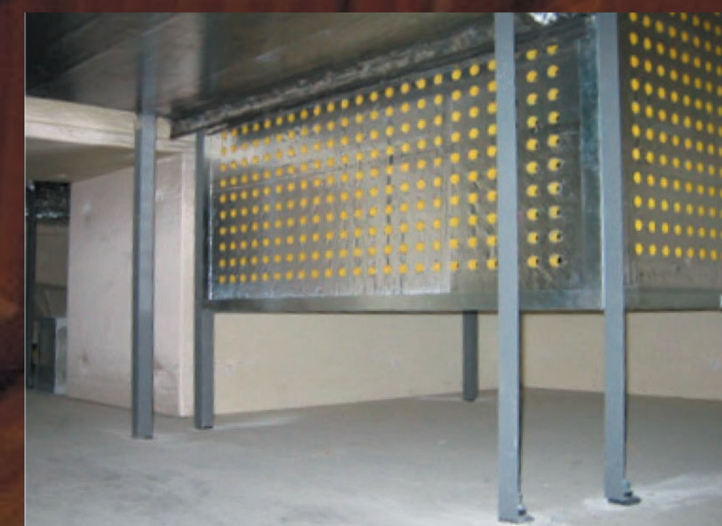
床下サプライチャンバー内に設けた穴あきガラスウールボードボックス <風量調整と消音の機能を兼ねる>
