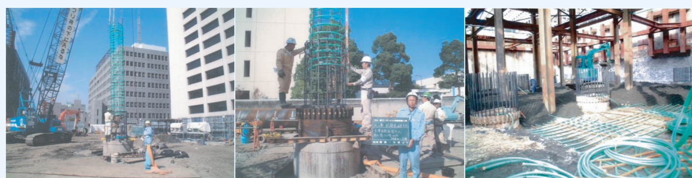
図-3 施工時の様子
