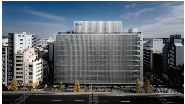
図1 西面ファサード 外観
