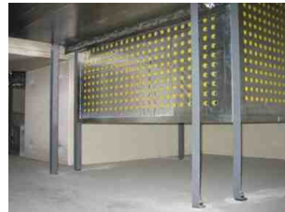
図 2.10 穴あきガラスウールボードボックス（風量の調整と消音の機能を兼ねている）
