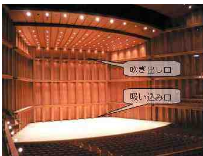
図 2.7 コンサート時の舞台空調（大ホール）
