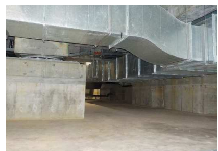
図-4 アースチューブ設置状況写真
