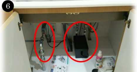
キッチンのガス・水の計量メーター
