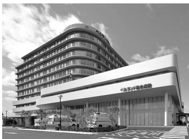
写真-1 建物外観
