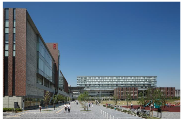
写真-1 建物外観
