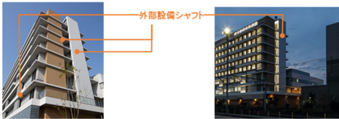
図-3 外部設備シャフト外観写真
