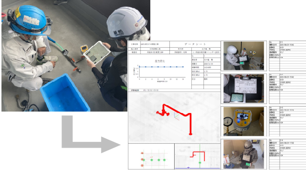
図7. 開発したシステムを用いた配管性能検査
