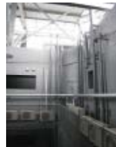
図9 ボイド内の縦シャフト
