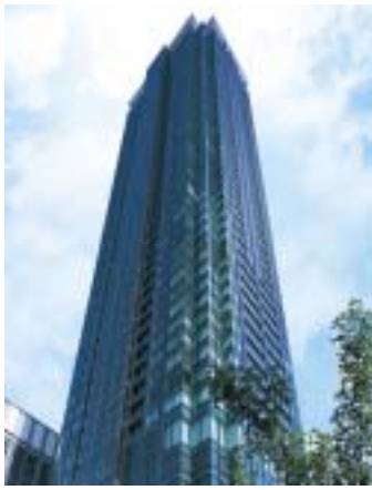
図1 ガラスカーテンウォールの外観
