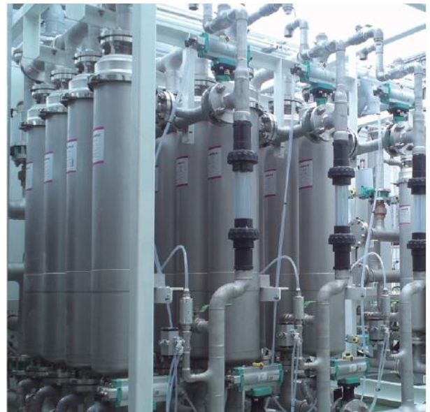
図4 逆洗排水回収装置実機画像
